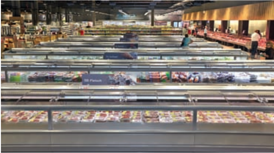
Nachweispflicht: Hersteller nutzen den Quickcheck, um die Förderfähigkeit der Anlagen zu belegen.
